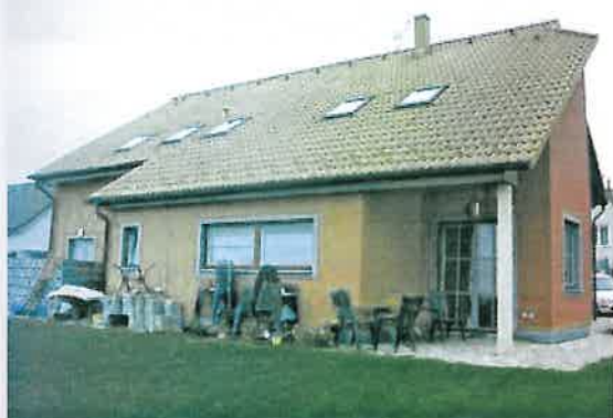
severozápadní pohled na pozemek ze zahrady
