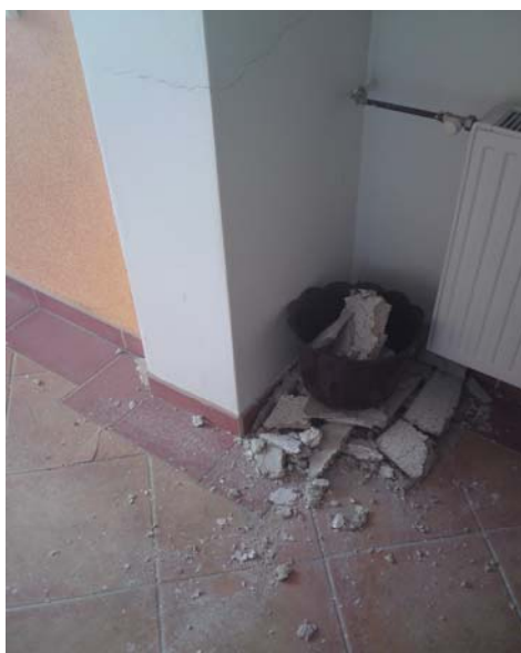
Poškození stropní konstrukce mezi 1. A 2. NP
