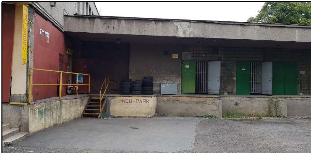
Zdroj: Fotografie pořízená znaleckým ústavem na místním šetření
