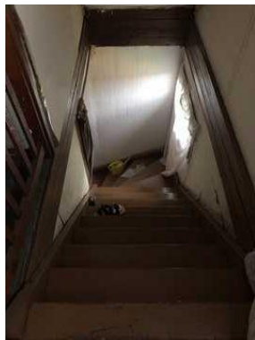
Schodiště na půdu z 1. NP
