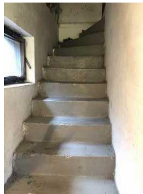
Betonové schodiště mezi 1. PP a 1. NP
