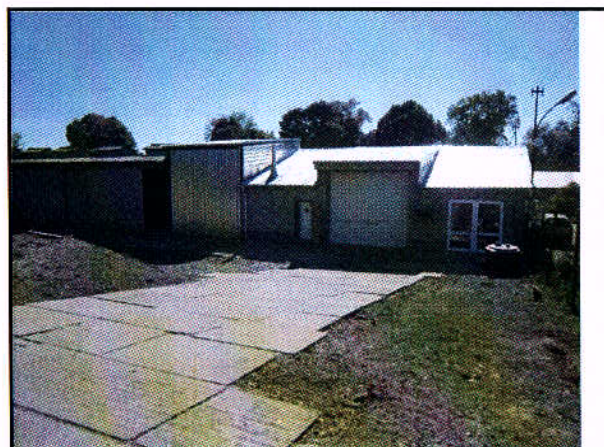
SNÍMEK Č. 5 – POZEMEK P.Č. 3761 – OSTATNÍ PLOCHA, MANIPULAČNÍ PLOCHA
