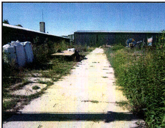
SNÍMEK Č. 2 – POZEMEK P.Č. 3757 – OSTATNÍ PLOCHA, MANIPULAČNÍ PLOCHA
