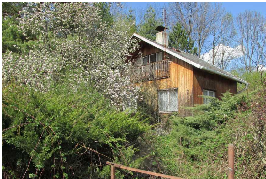
Pohled uliční na chatu č. ev. 57
