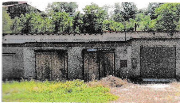
Pohled z čelního pohledu, garáž je 2. zprava
