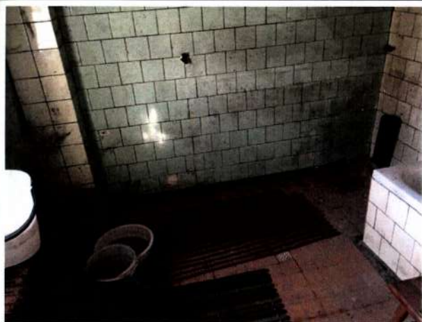
Stavba č.p. 192 – rod. dům, na p.č. 2154, pohled vnitřní č. 3, koupelna, ze dne 1. 2. 2019
