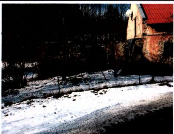
Torzo vedlejší stavby, na p.č. 2154, pohled zvenčí č. 1, ze dne 1. 2. 2019
