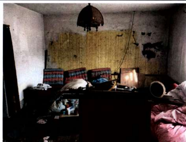
Stavba č.p. 192 – rod. dům, na p.č. 2154, pohled vnitřní č. 4, obývací pokoj, ze dne 1. 2. 2019
