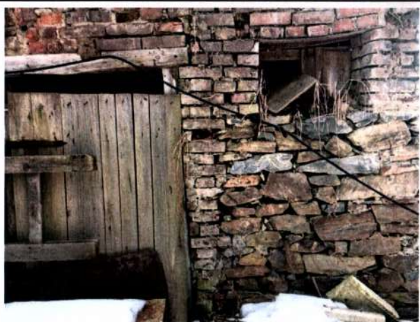
Suché WC, na p.č. 2154, pohled zvenčí č. 1, ze dne 1. 2. 2019
