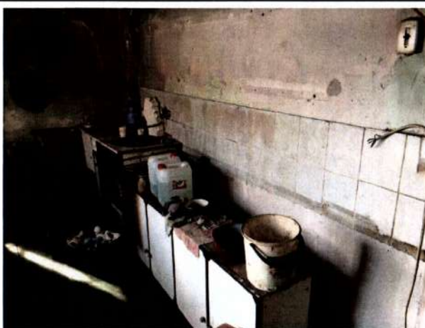
Stavba č.p. 192 – rod. dům, na p.č. 2154, pohled vnitřní č. 1, kuchyně, ze dne 1. 2. 2019
