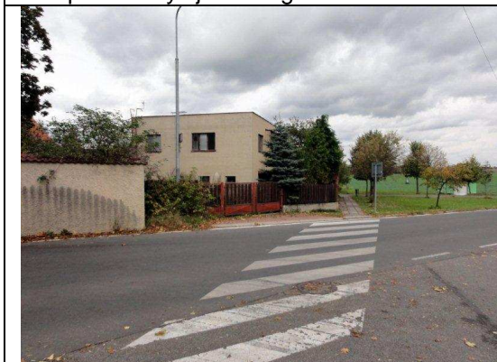
Pohled z ulice Mstěnická
