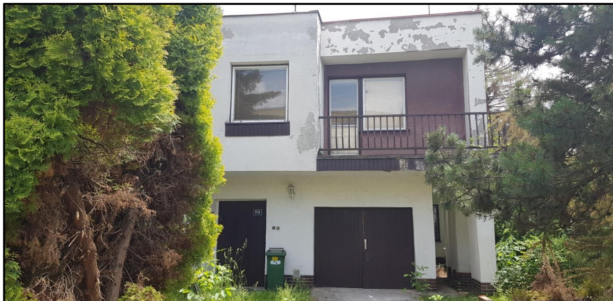
Fotografie 2 Pohled mj. na rodinný dům č. p. 8 na pozemku p. č. St. 1828
