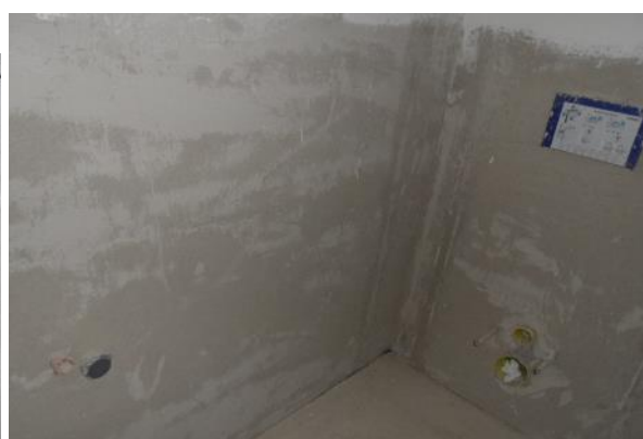
v samostatném WC je příprava na WC typu Geberit a na umyvadlo
