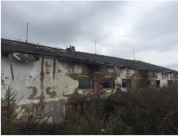
Pohled na zem. stavbu (sklad)
