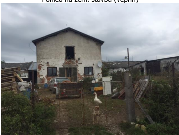
Pohled na zem. stavbu (z části obyvatelná část)
