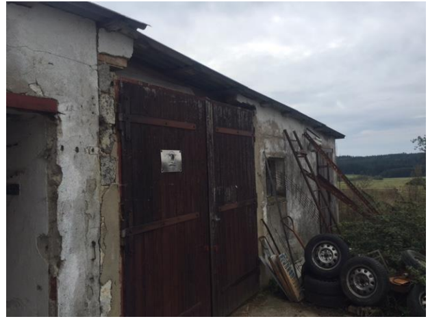
Pohled na zem. stavbu (sklad)
