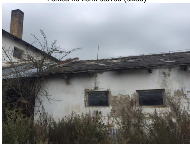
Pohled na zem. stavbu (sklad)
