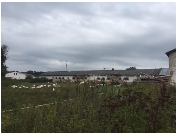
Pohled na zem. stavbu (vepřín)
