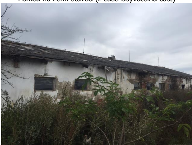
Pohled na zem. stavbu (sklad)
