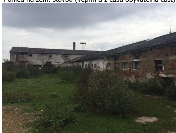
Pohled na zem. stavbu (sklad)
