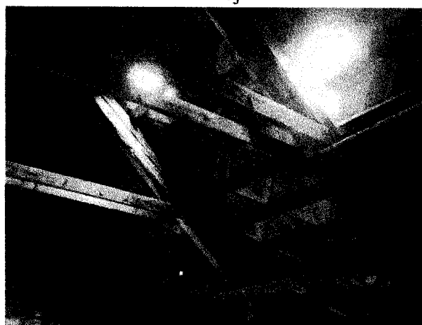
Půda s poškozenou krytinou střechy
