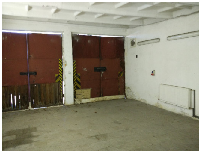
Garáž v garážovém objektu
