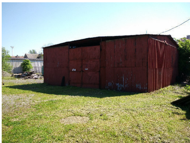
Neužívaná ocelová hala
