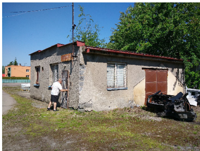
Objekt s garáží a skladem parc.č. 165/3
