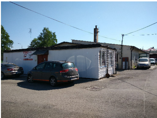
Hlavní objekt č.p. 422, v popředí administrativní část, za ní dílny a sklady
