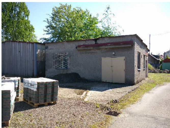
Objekt s garáží a skladem parc.č. 165/3
