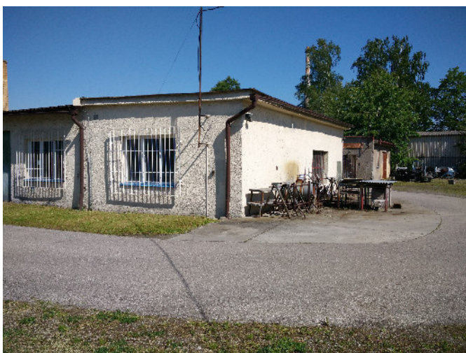
Zadní část hlavního objektu
