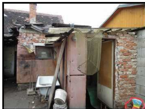
Pohled ze dvorku - přístřešek nad schody do sklepa
