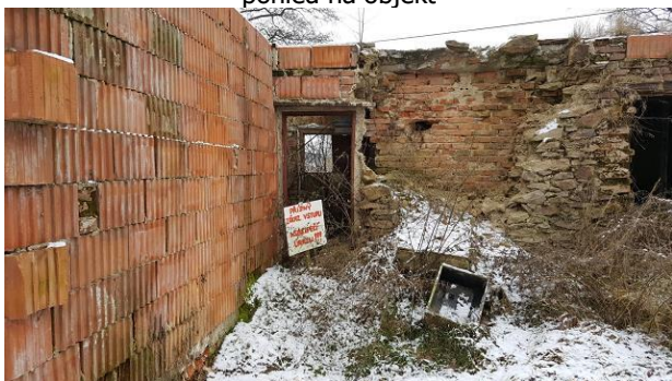
pohled na objekt
