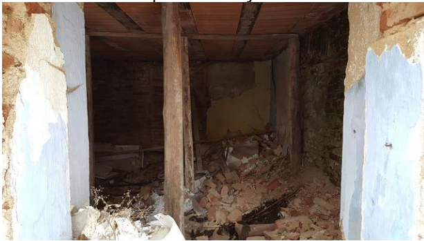
pohled na objekt
