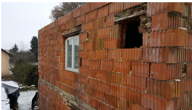
pohled na objekt
