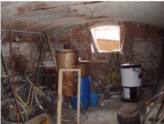
Objekt bydlení na části st.p.č. 280 - sklepní prostory
