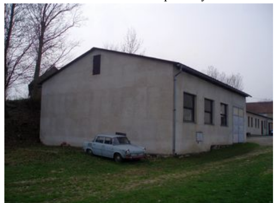
Rozestavěná stavba na části st.p.č. 279/1, st.p.č. 279/2 - sklad - pohled severovýchodní
