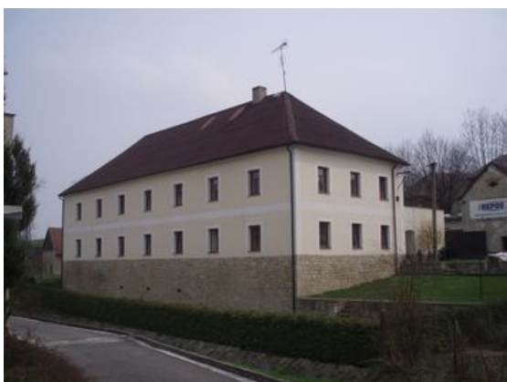
Budova č.p. 18 - pohled západní
