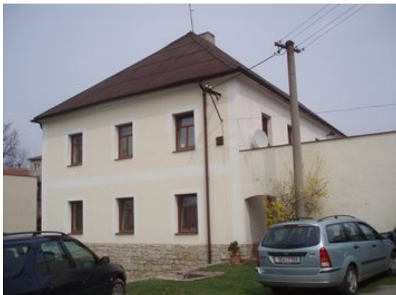
Budova č.p. 18 - pohled jižní
