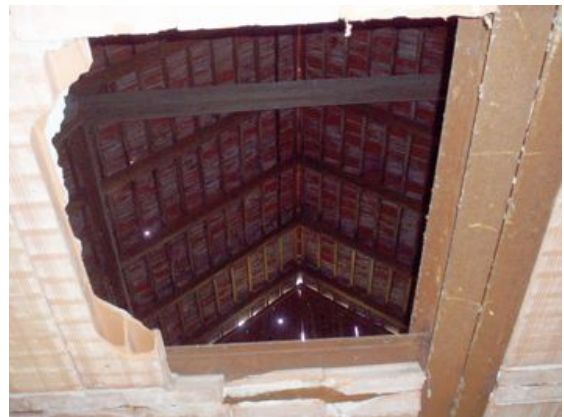
Budova bez čp/če na st.p.č. 15 - vnitřní prostory
