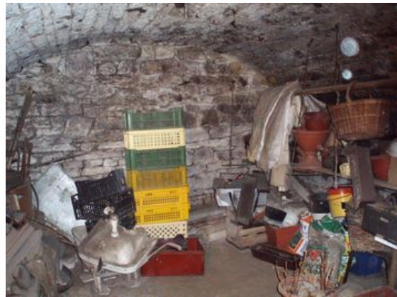
Budova č.p. 18 - sklepní prostory
