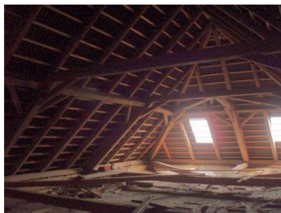
Budova č.p. 18 - půdní prostory
