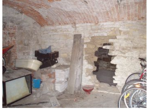
Objekt bydlení na části st.p.č. 280 - sklepní prostory
