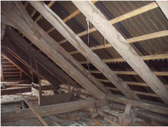
Budova č.p. 18 - půdní prostory
