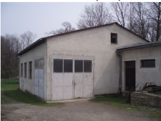
Rozestavěná stavba na části st.p.č. 279/1, st.p.č. 279/2 - sklad - pohled západní
