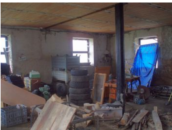
Budova bez čp/če na st.p.č. 15 - vnitřní prostory
