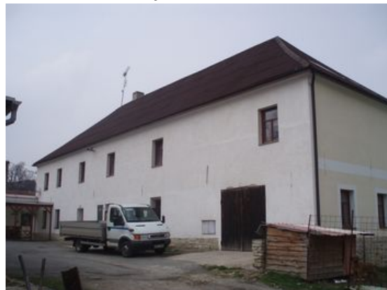
Budova č.p. 18 - pohled východní
