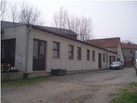
Rozestavěná stavba na části st.p.č. 280 - prodejna, sklad - pohled severovýchodní
