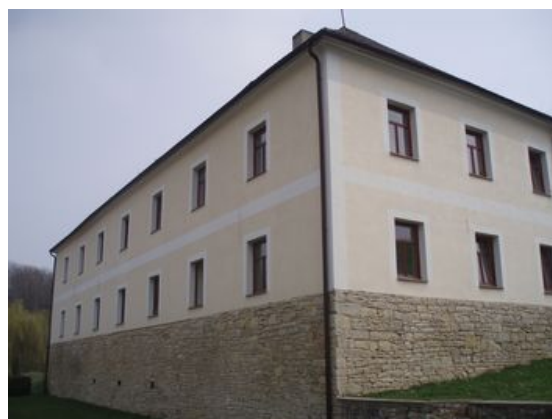
Budova č.p. 18 - pohled západní
