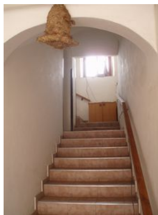
Budova č.p. 18 - vnitřní schodiště do 2.NP
