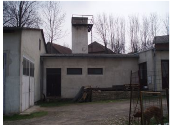
Rozestavěná stavba na části st.p.č. 279/1 - kotelna - pohled severozápadní
