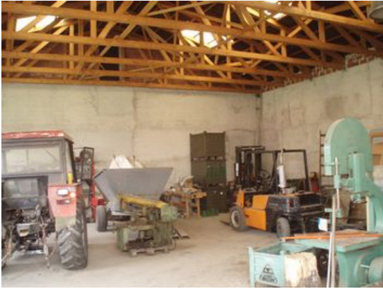
Rozestavěná stavba na části st.p.č. 279/1, st.p.č. 279/2 - sklad - vnitřní prostory
