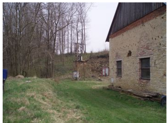
Trafostanice TS Makov SY_0018 na p.p.č. 575
