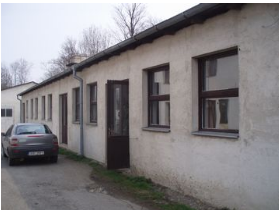
Rozestavěná stavba na části st.p.č. 280 - prodejna, sklad - pohled západní
