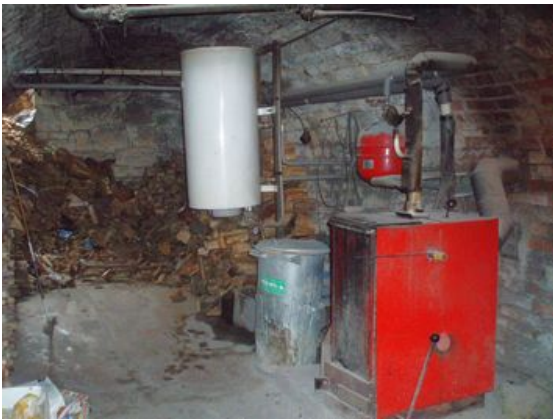
Budova č.p. 18 - sklepní prostory
