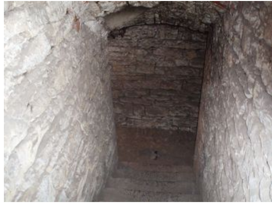
Budova č.p. 18 - schodiště do sklepa
