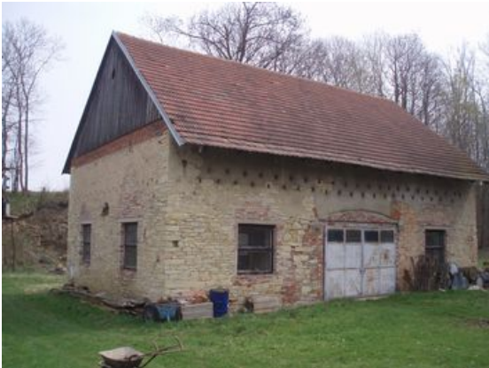
Budova bez čp/če na st.p.č. 15 - pohled severozápadní
