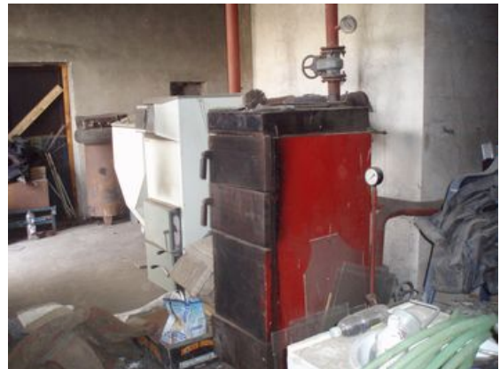
Rozestavěná stavba na části st.p.č. 279/1 - kotelna - vnitřní prostory
