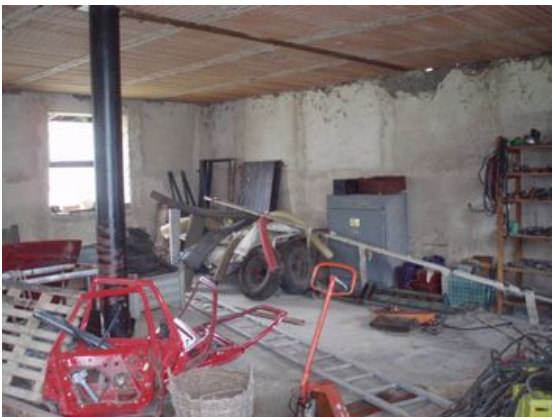
Budova bez čp/če na st.p.č. 15 - vnitřní prostory
