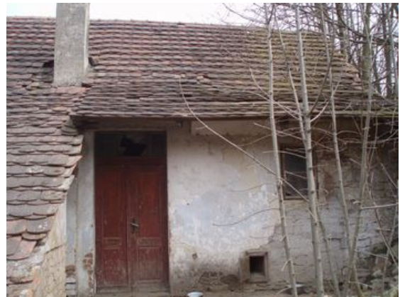
Objekt bydlení na části st.p.č. 280 - vstup do obytné části
