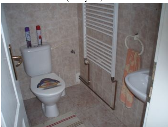
Budova č.p. 18 - 2.NP - prostory bývalých kancelářů (soc. zařízení)
