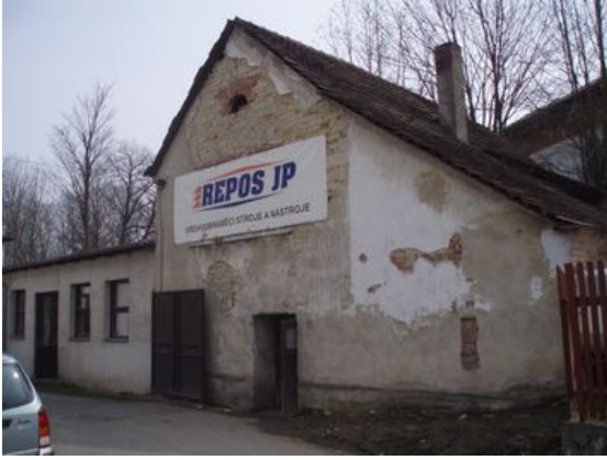
Objekt bydlení na části st.p.č. 280 - pohled severozápadní
