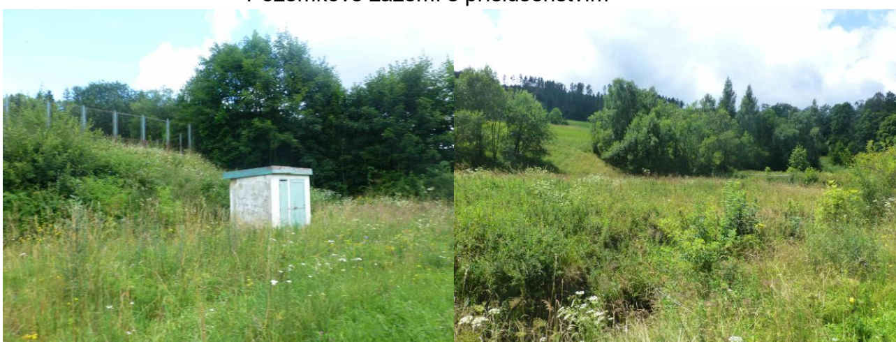
Pozemkové zázemí s ČOV
