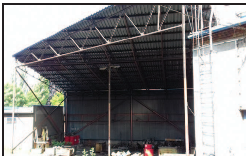
Přístřešek u kotelny
