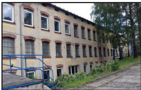
Objekt dílen a skladů
