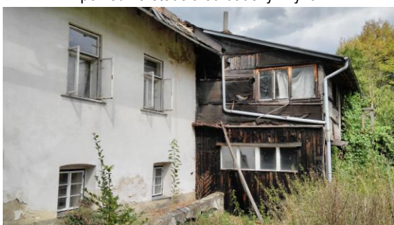
pohled na budovu mlýna z JV strany
