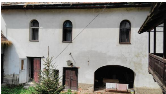
pohled na dům č. p. 51 určený k bydlení ze dvora
