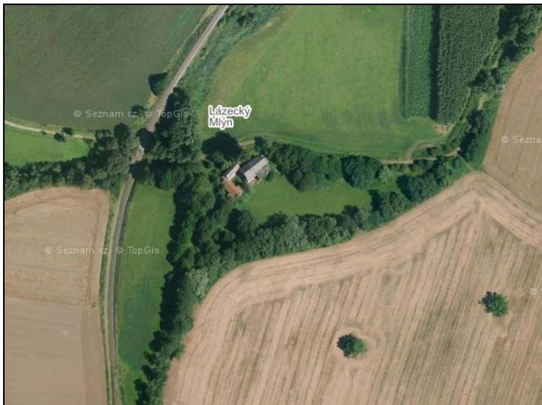
Obr. č. 4: Výřez z letecké mapy znázorňující umístění oceňovaných nem. věcí a jejich nejbližší okolí.
