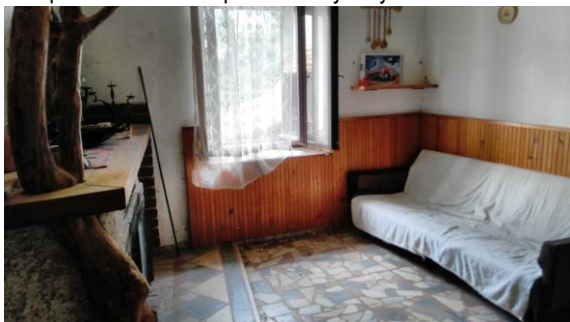
prostor obyvatelné části domu č.p. 51 v 2.NP
