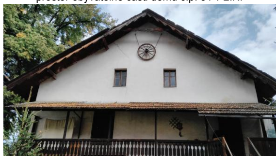
pohled na 2.NP budovy mlýna ze dvora
