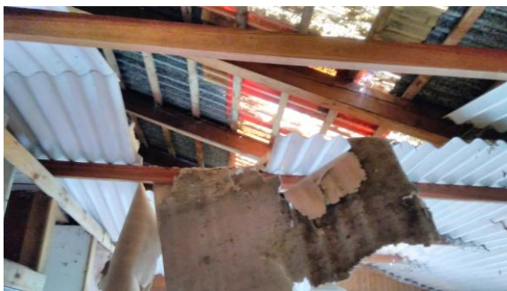
střešní konstrukce v části budovy mlýna
