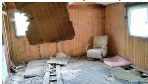
původní pokoj v budově mlýna v 2.NP
