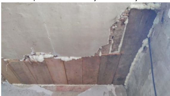
pohled na strop budovy mlýnu v 2.NP
