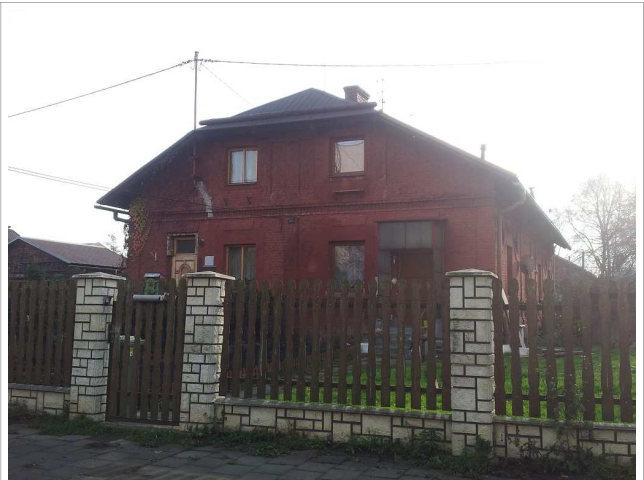
Pohled na dům od severozápadu- z příjezdové komunikace ulice Erbenova
