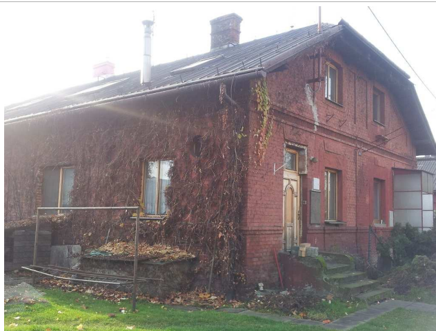
Pohled na dům od severu
