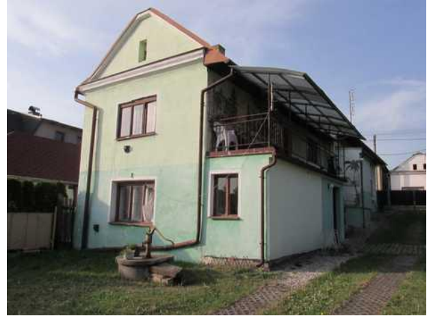
Dvorní pohled na dům
