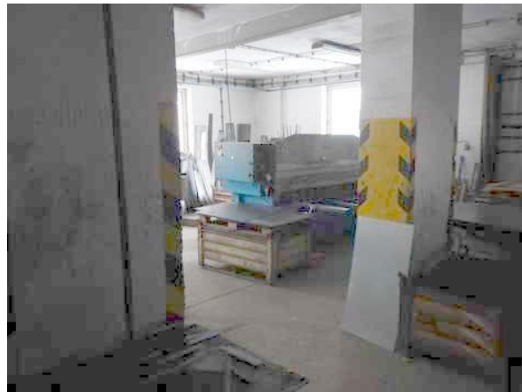
Dílna - budova čp. 49 na p. St. 301/1
