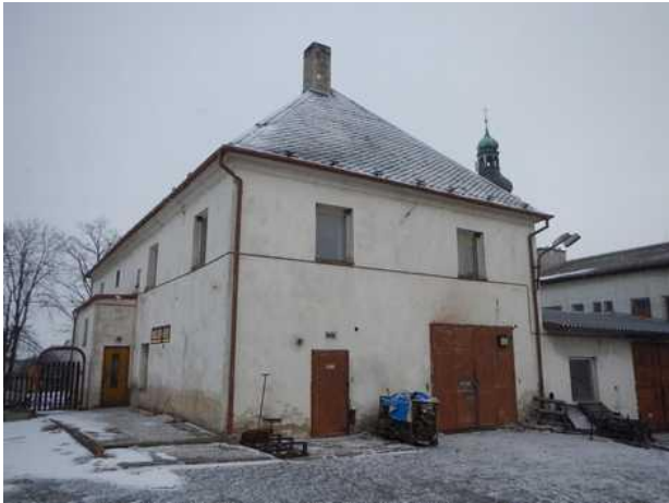
Budova čp. 49 na pozemku 301/1
