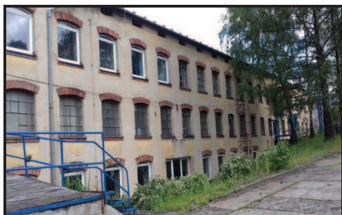
Objekt dílen a skladů
