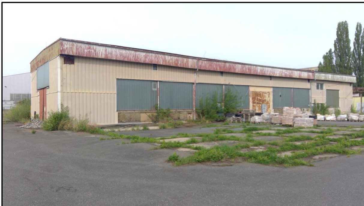
Fotodokumentace pořízená znaleckým ústavem na místním šetření
