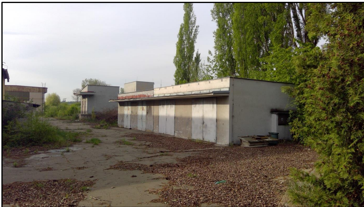
Fotodokumentace pořízená znaleckým ústavem na místním šetření
