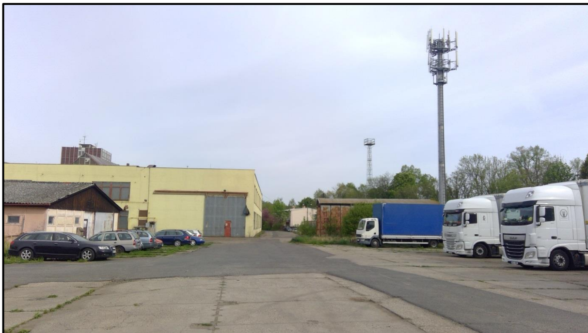
Fotodokumentace pořízená znaleckým ústavem na místním šetření
