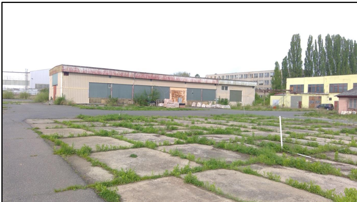
Fotodokumentace pořízená znaleckým ústavem na místním šetření
