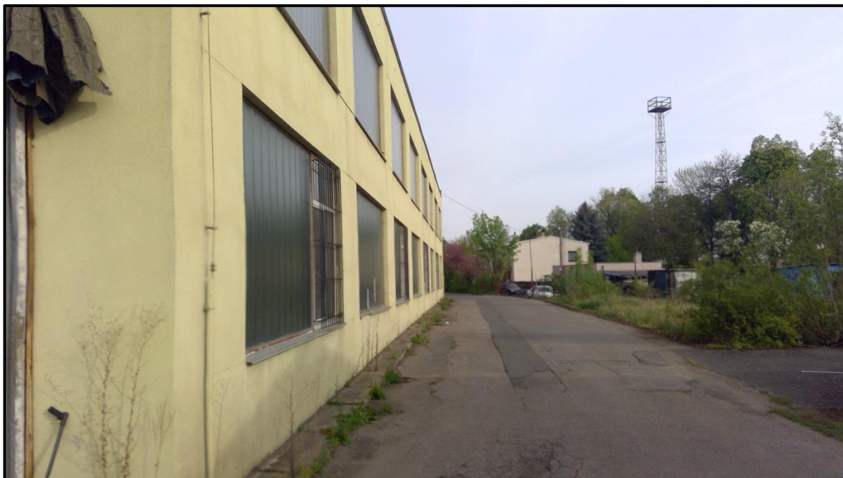
Fotodokumentace pořízená znaleckým ústavem na místním šetření
