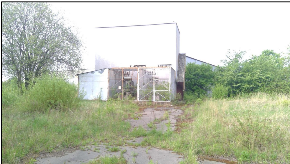
Fotodokumentace pořízená znaleckým ústavem na místním šetření
