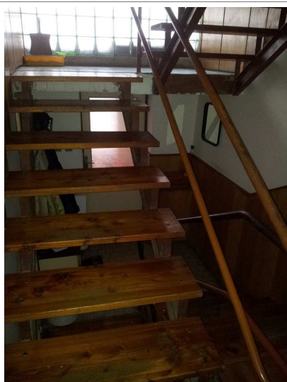
Schodiště do podkroví
