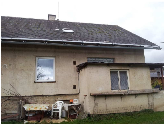
Pohled na přístavek-vstup - z jihovýchodu
