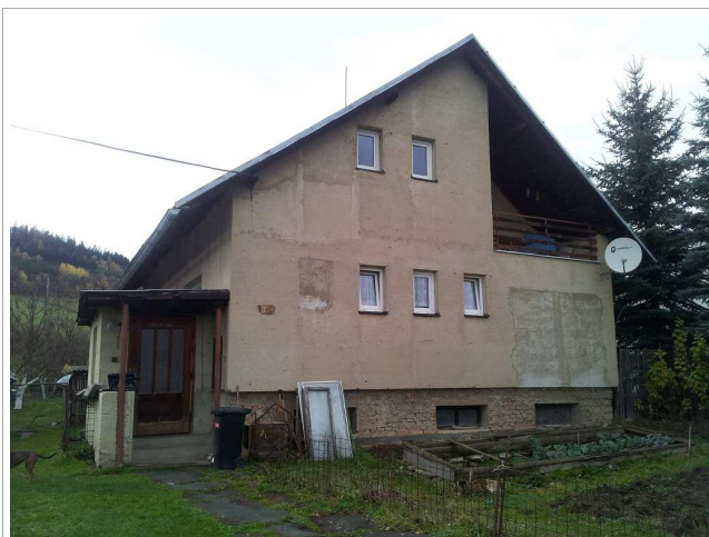
Pohled od jihu
