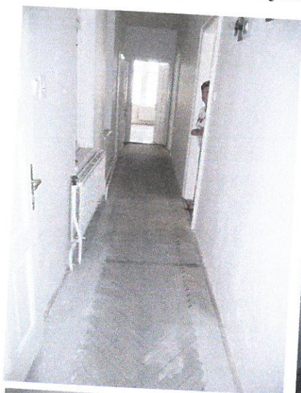
Prostory bytu ve 2. nadzemním podlaží objektu:
