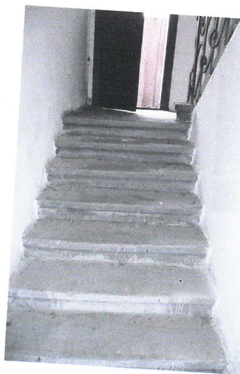
Schodiště propojující jednotlivá podlaží stavby:
