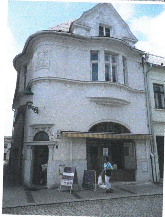
Průčelí do ulice Fryštátská
