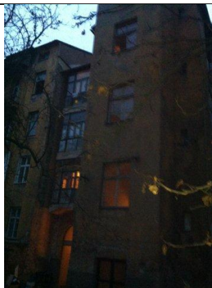
Bytový dům - pohled z vnitrobloku
