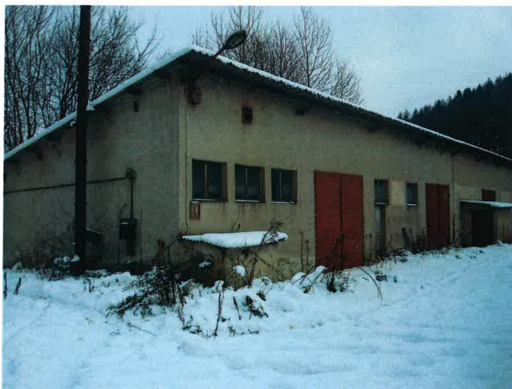
Pohled na objekt bez čp/če (objekt pomocných provozů) na pozemku parc. č. St. 507/1
