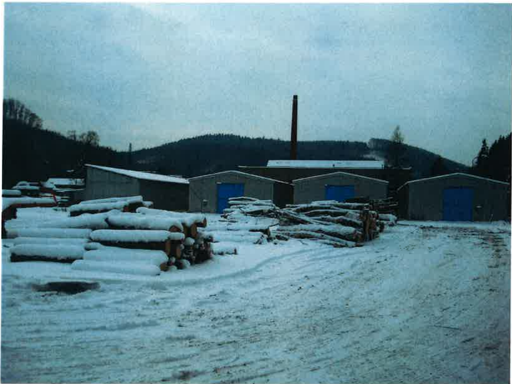
Pohled na objekty bez čp/če (ocelokolny A, B, C) na pozemcích parc. č. St. 111, St. 112, St. 113 a sklad šamotu na parc. č. St.114
