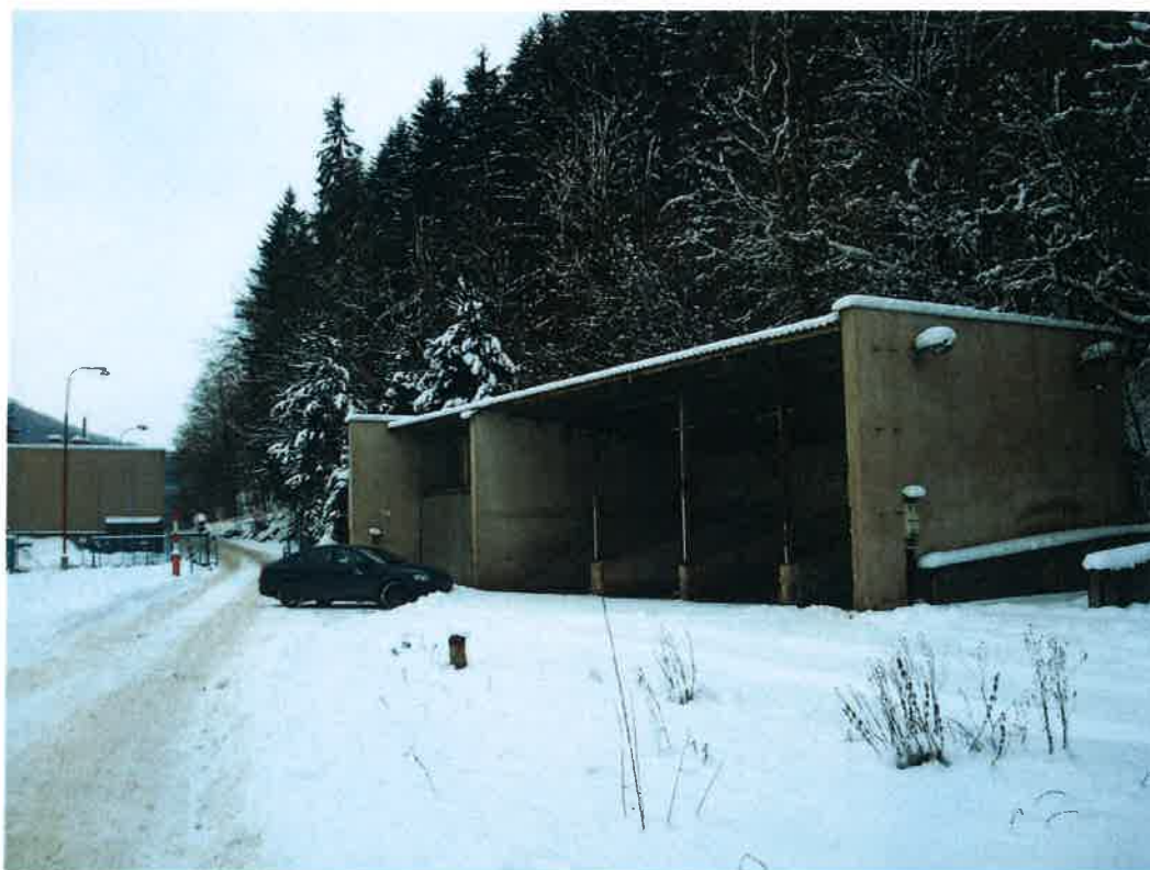
Pohled na objekt skladu odpadů na pozemku parc. č. 311/1
