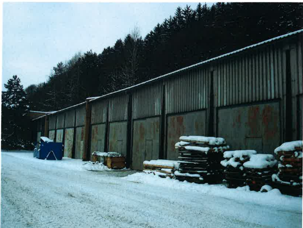
Pohled na objekt bez čp/če (přístřešek LM a garáže – dílny autodopravy) na pozemcích parc. č. St. 512 a St. 110
