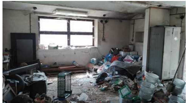
interiér hospodářské budovy
