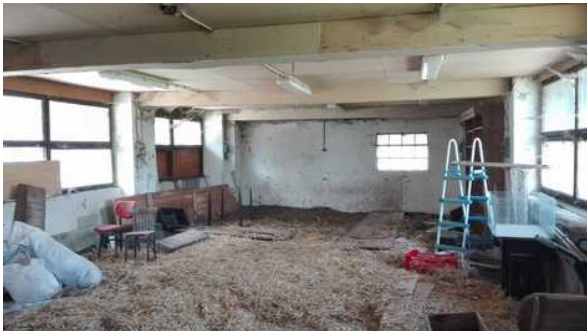
interiér hospodářské budovy
