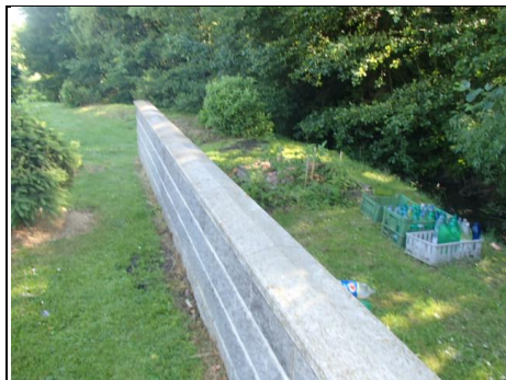
Opěrná zeď (ztracené bednění)
