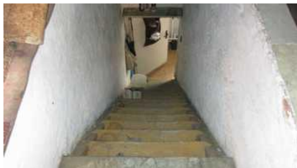
Schody na půdu
