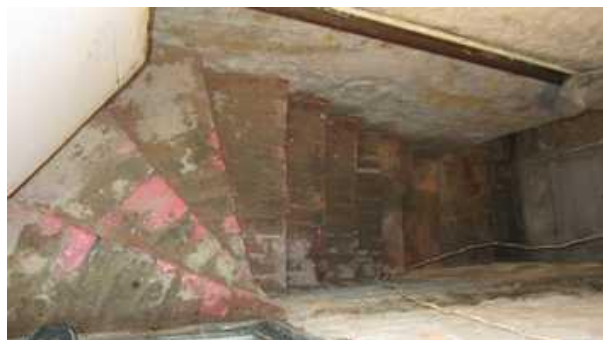
Schody do sklepa
