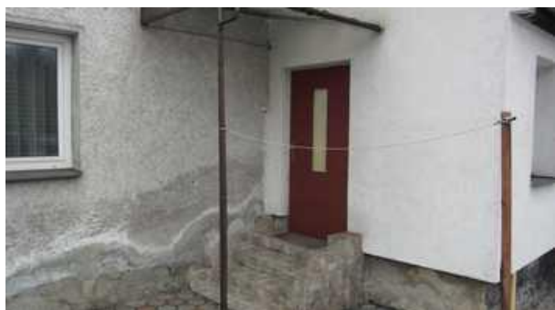
Hlavní vstup do RD
