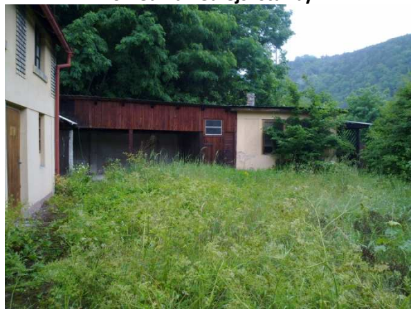
Pohled na vedlejší stavby
