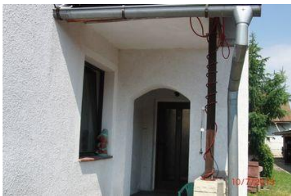
Pohled přední na vchod
