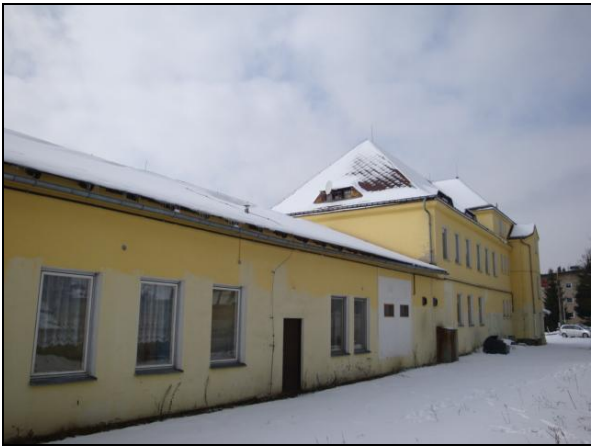
pohled na dvorní trakt budovy
