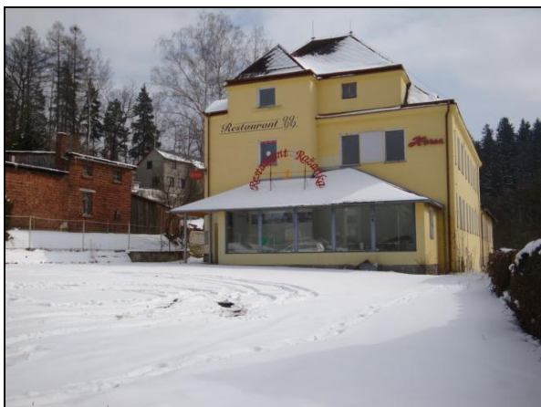
pohled na parkoviště a budovu č.p. 286
