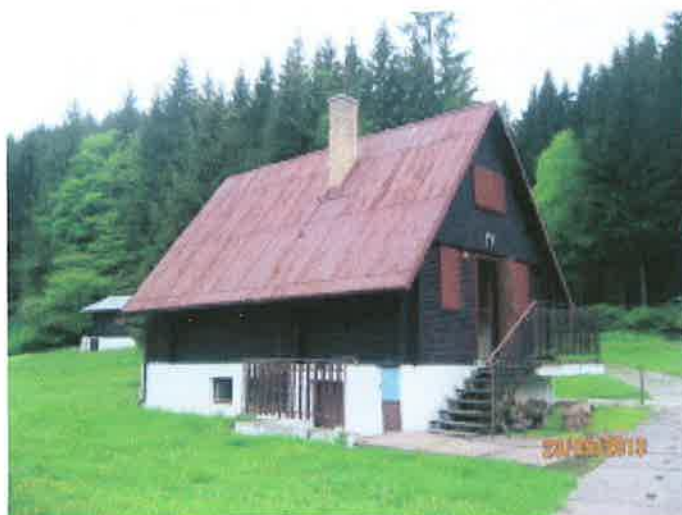
detail – rekreační objekt – chata
