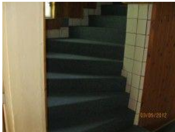
schodiště do podkroví
