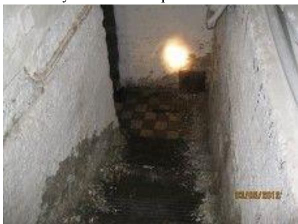
schody do suterénu
