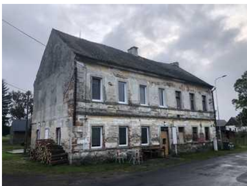
Pohled na bytový dům z příjezdové komunikace
