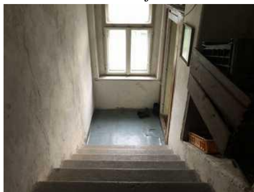
Schodiště k bytové jednotce
