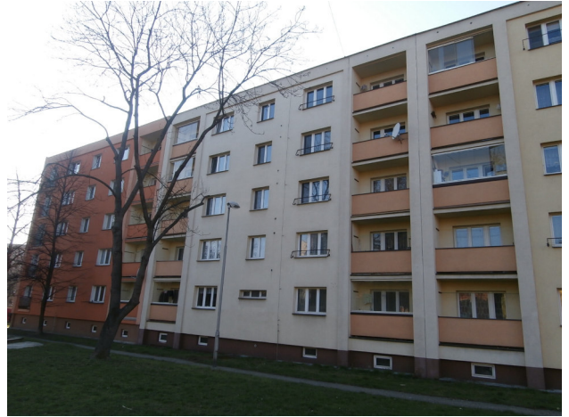
Bytový dům č.p. 2097 pohled na JV stranu
