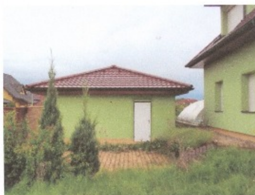
Pohled severovýchodní (vedlejší objekt, garáž)
