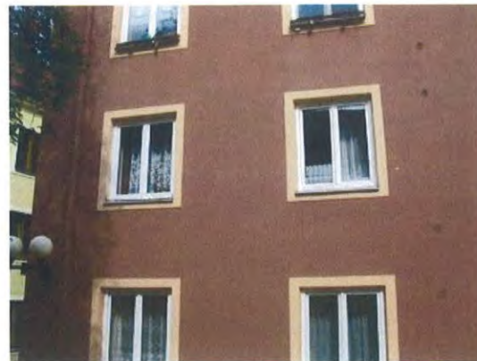
Pohled na okna bytu ve 2.NP
