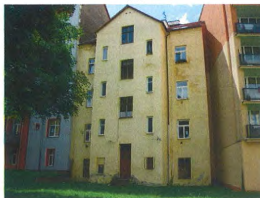
východní zadní pohled z dvorního traktu
