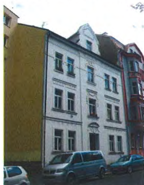
severozápadní pohled z Komenského ulice
