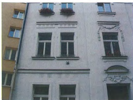
Pohled na okna bytu ve 2.NP z ulice
