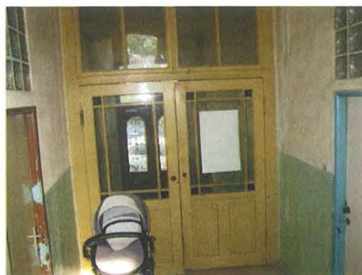
vstupní chodba se schodištěm v 1.NP
