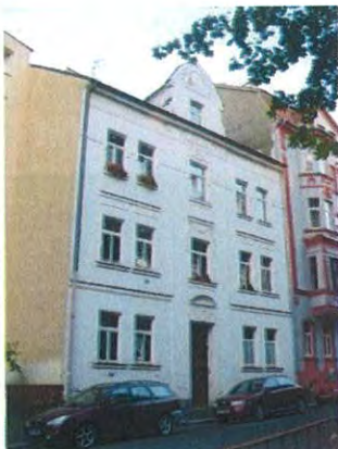
severozápadní pohled z Komenského ulice
