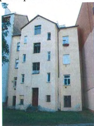
východní zadní pohled z dvorního traktu
