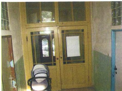
vstupní chodba se schodištěm v 1.NP
