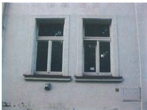
Pohled na okna bytu v 1.NP z ulice
