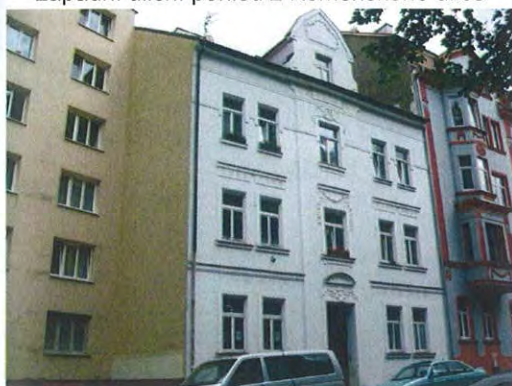
severozápadní pohled z Komenského ulice
