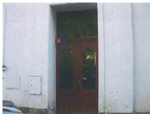
Vstupní dveře do bytového domu
